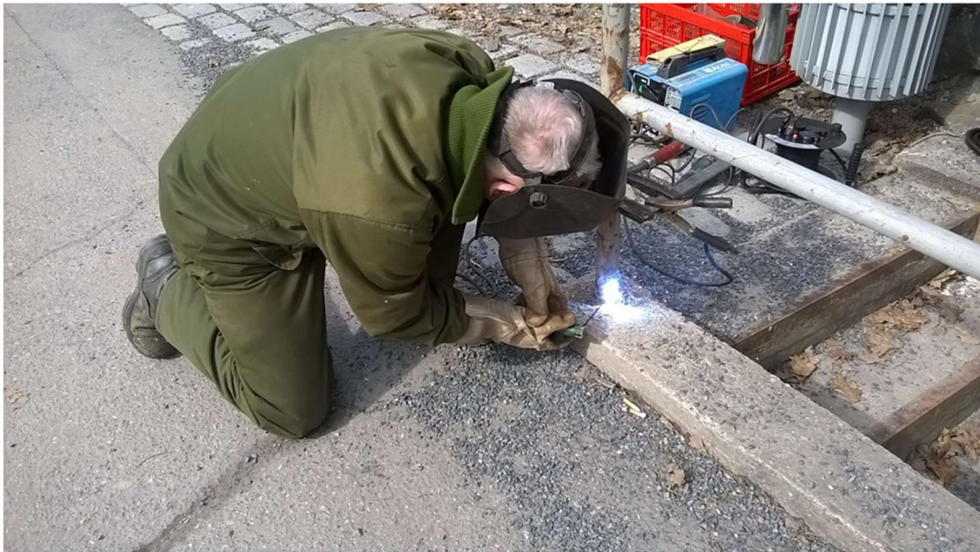
Seppo Kiiski hitsaa LOKIN sisäänkäynnin kaidetta
